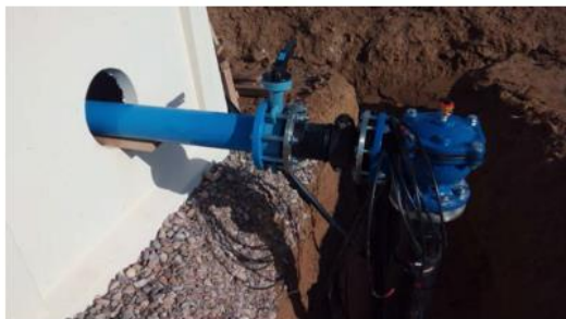
Válvula seccionadora y válvula hidráulica
