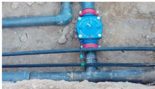
Válvula hidráulica enterrada
